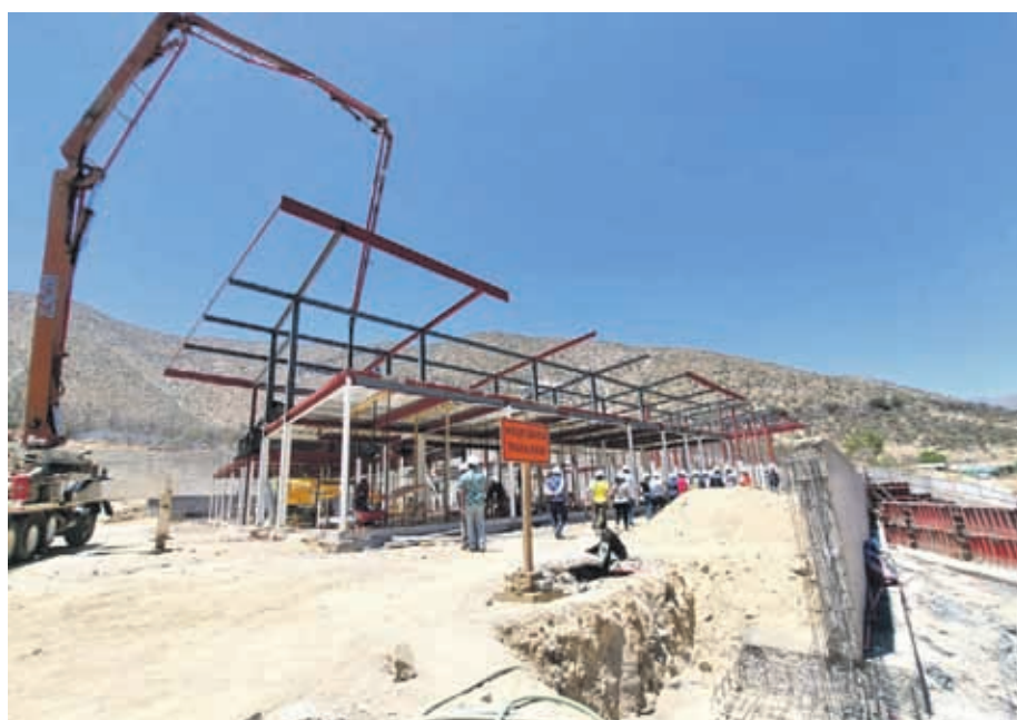
Así luce actualmente la construcción del CESFAM de Carén.
